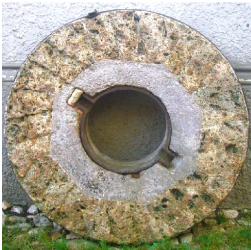
Quarzmühlstein, sogenannter „Franzose“, aus der Donauältheimer Mühle. In dessen Mitte der sogenannte „Schluck“ aus grauem Sandstein.
