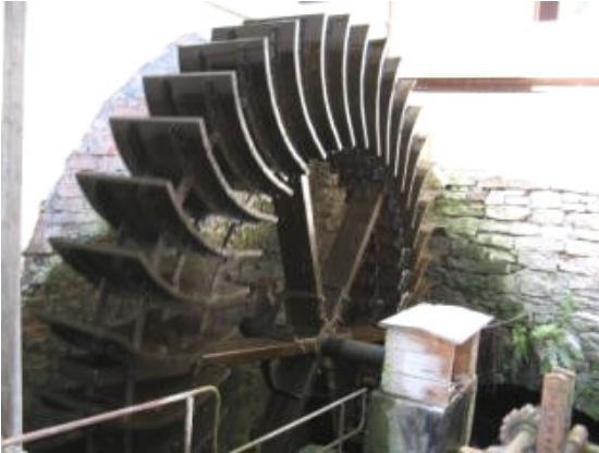
Unterschlächtiges Wasserrad der Fuchsmühle an der Tauber, Rothenburg
